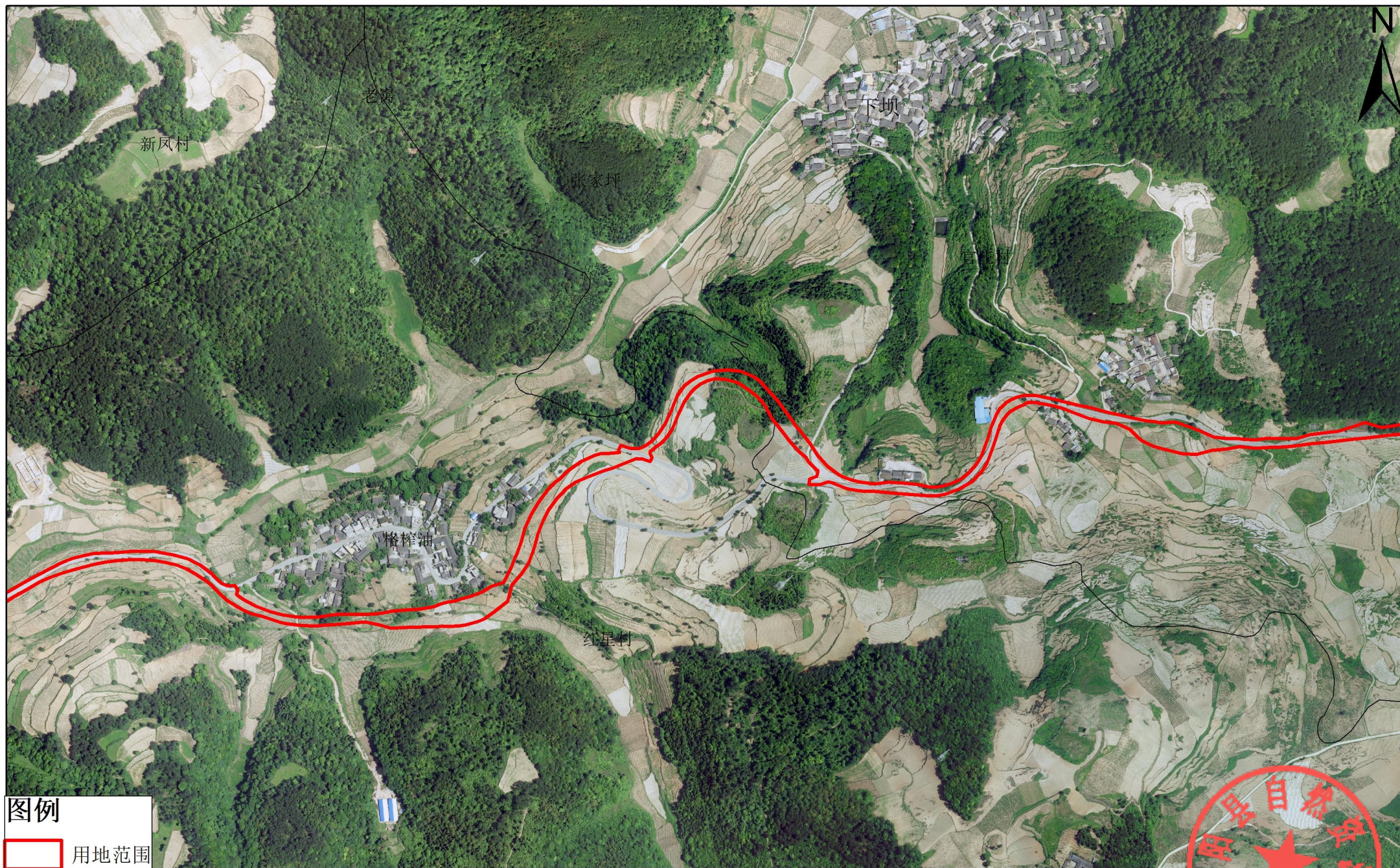
开阳县堰塘村至临江村道路工程项目影像图3
